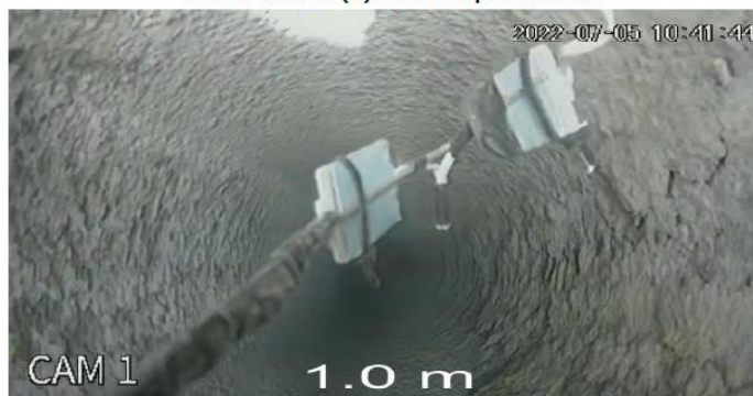
Foto N°1: A un (1) metro de profundidad.
